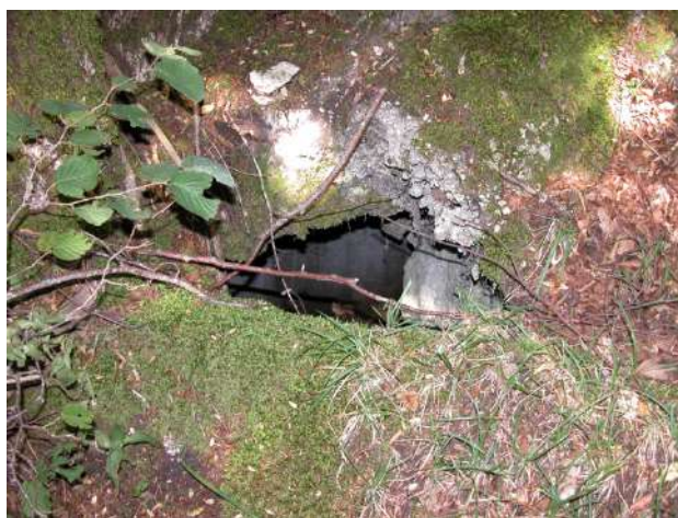
Figura 16 pozzo/cisterna per l'acqua piovana
